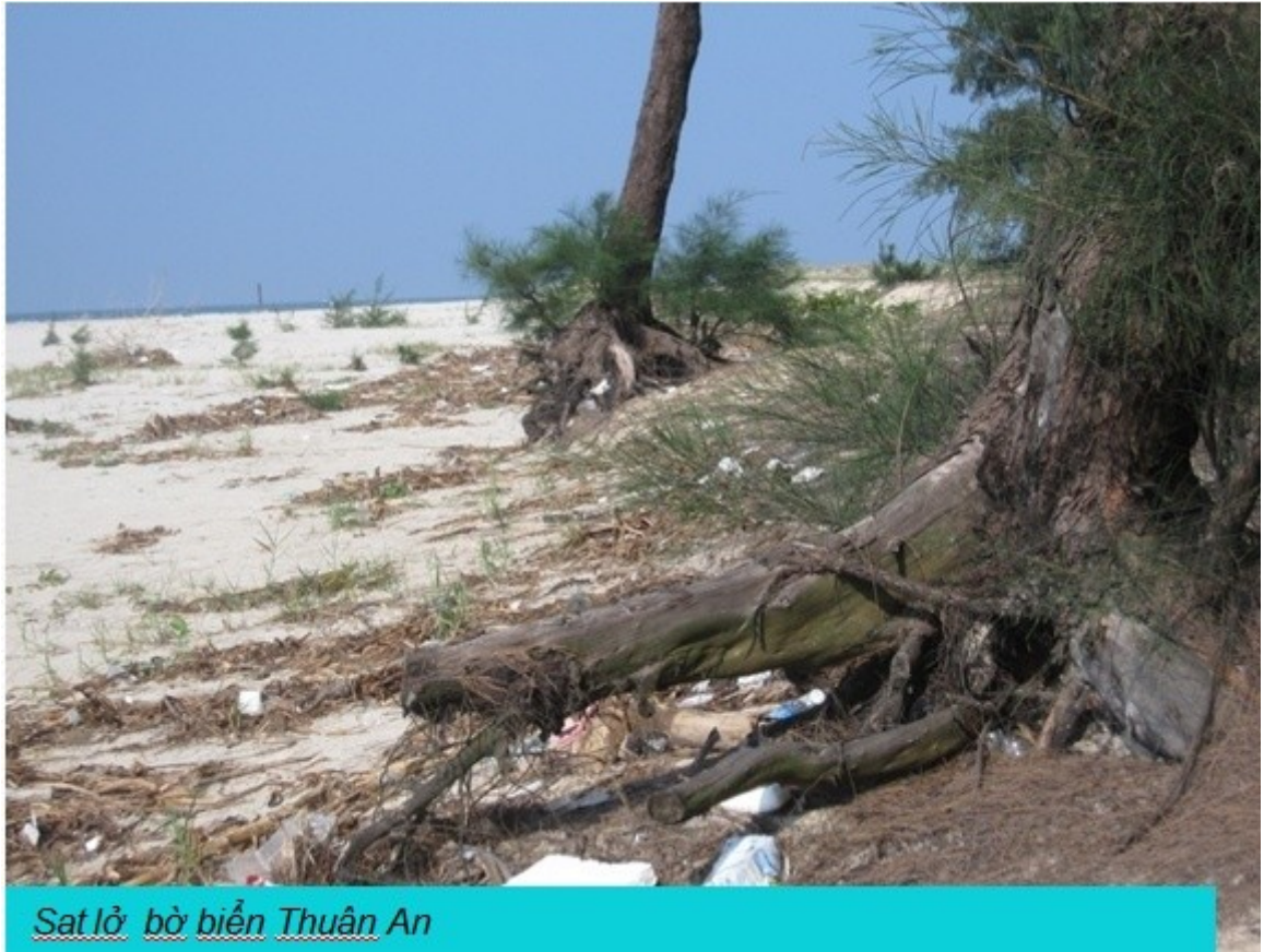
Hình 14. Sạt lở bờ biển Thuận An
